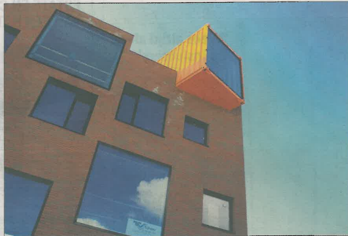
■ De gele container (2750 kilo) op het dak levert een opmerkelijk architectonisch beeld op. foto Tom van Dijke
